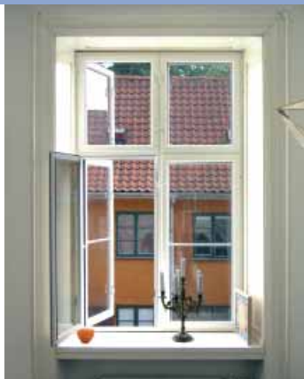
Dannebrogsvindue energirenoveret med forsatsrammer (se nederst til venstre)
