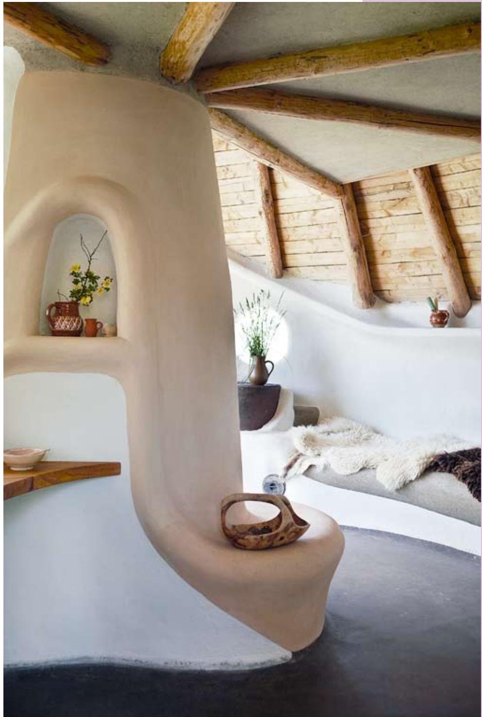
COB huset hos Fornyset Energi i Stenlille: Lokale materialer: ler, sand, halm, granrafter. Langhalm på taget. Hvor langt kan vi komme med lokale naturlige materialer? Foto: Kira Brandt
